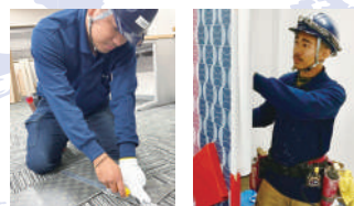
床タイルカーペット施工中 クロス工事施工中
